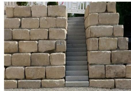
Trockenmauern werden zum Bau von Mauerwerken, Hangbefestigungen und Stufen verwendet. Sie dienen als Lärmschutz und Rahmen für ein Grundstück oder als Raumteiler im Garten. Fachgerecht verarbeitet überdauern Trockenmauern Jahrhunderte.
